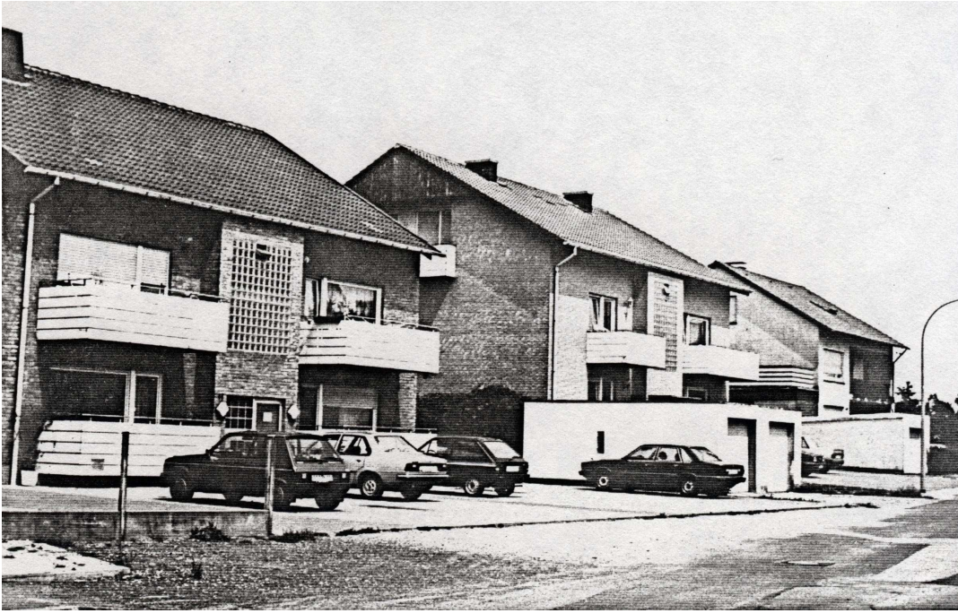
Oben: Twiete Reihenhausbebauung
