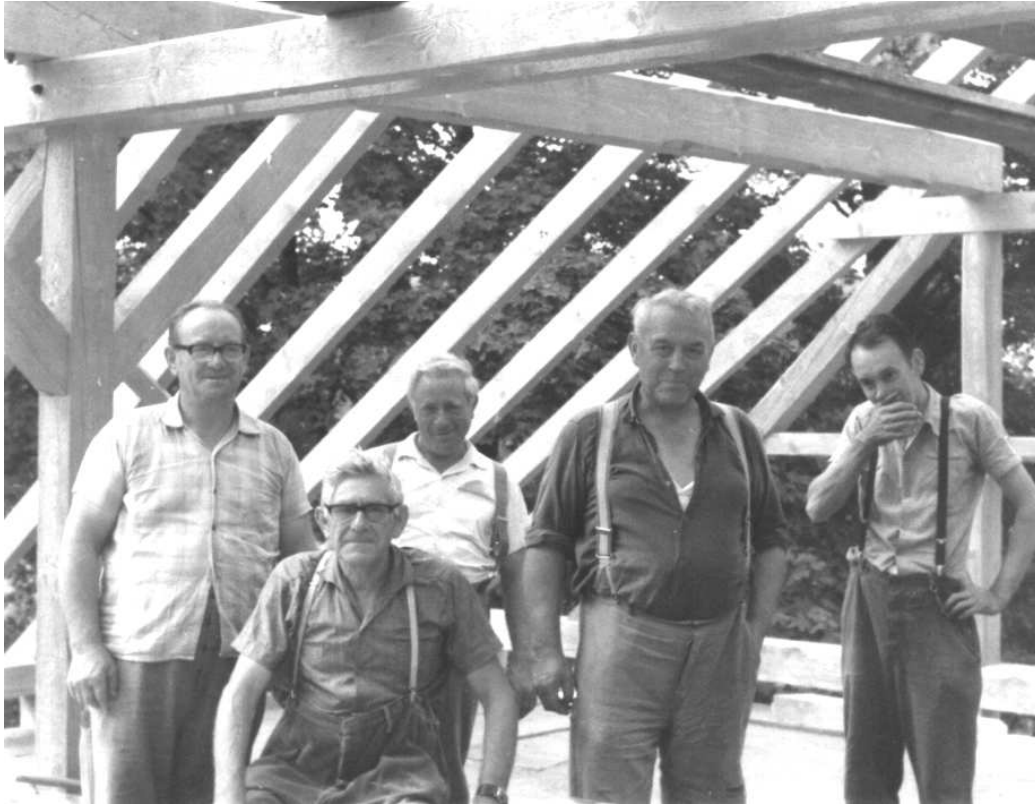
Richtfest auf dem Borghof (Bußmann, heute Wäsch), das Dach ist 1978 gedreht worden.
