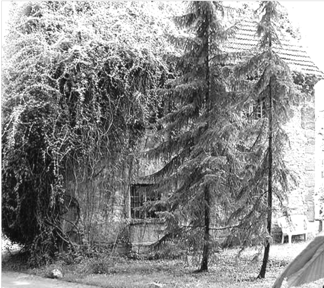
Backhaus 19 Jh. auf dem Riehenhof (Risse) im Jahre 2000.
