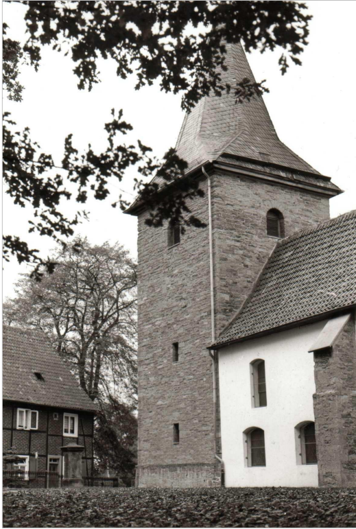
St. Matthias, Mittelschiff mit verputztem Mauerwerk 1979. Blick nach Westen, links die Gaststätte Bals.
